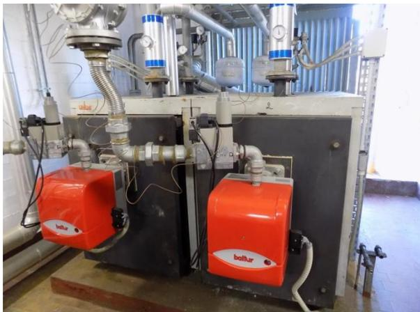
Figura 4.15 - Particolare del generatore di calore a servizio della scuola media
