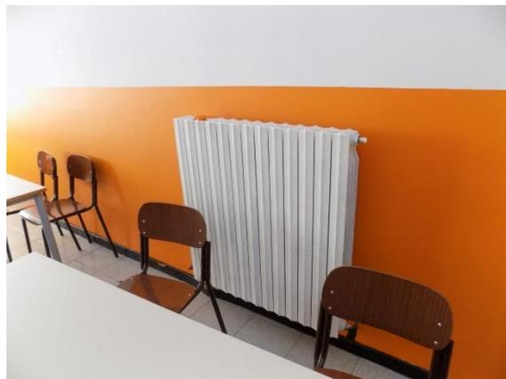
Figura 4.7 – Particolare di un radiatore installato in una zona di circolazione della scuola elementare
