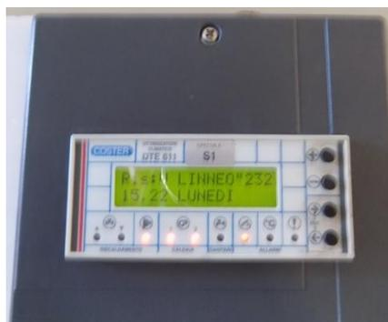
Figura 4.10 - Particolare della centralina di controllo all'interno della centrale termica a servizio della scuola media
