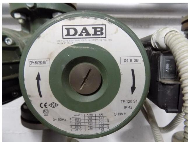
L'installazione di un circolatore elettronico a velocità variabile permette di ottimizzare tutte le prestazioni dell'impianto anche in termini di energia elettrica necessaria per l'alimentazione degli organi ausiliari. Inoltre viene prolungata la vita della pompa stessa.
